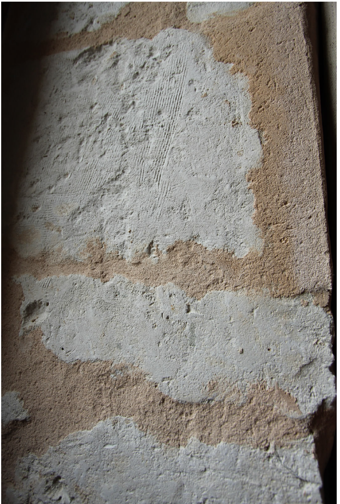
pierre et enduit chaux et sable
